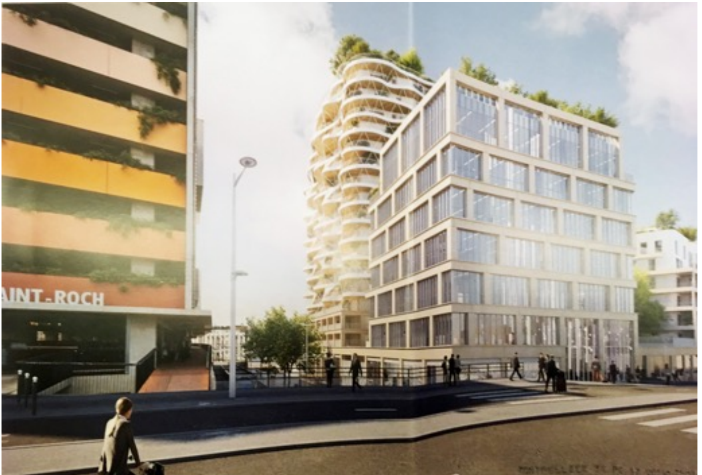
Vue du pont de Sète
